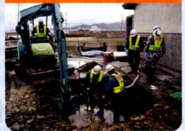
平成23年3月28日 石巻市字館下 送水管復旧
